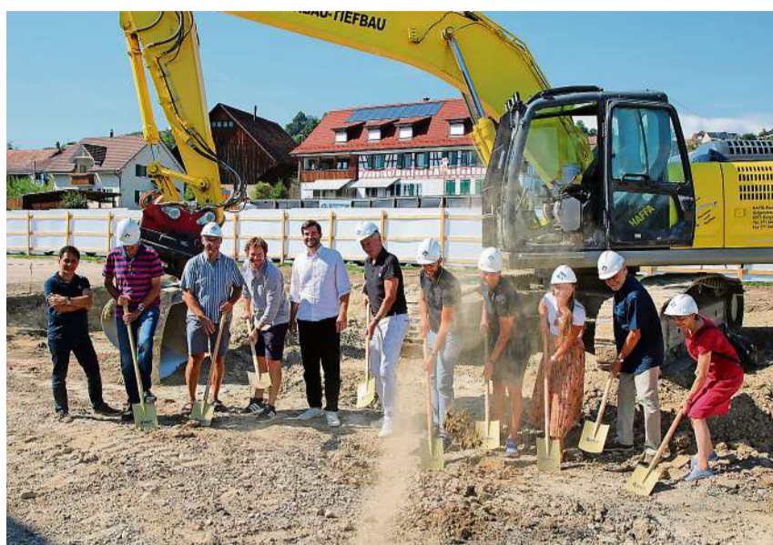
Die Häberlin AG lud zukünftige Anwohner zum Spatenstich nach Uesslingen. Nico Wrzeszcz
