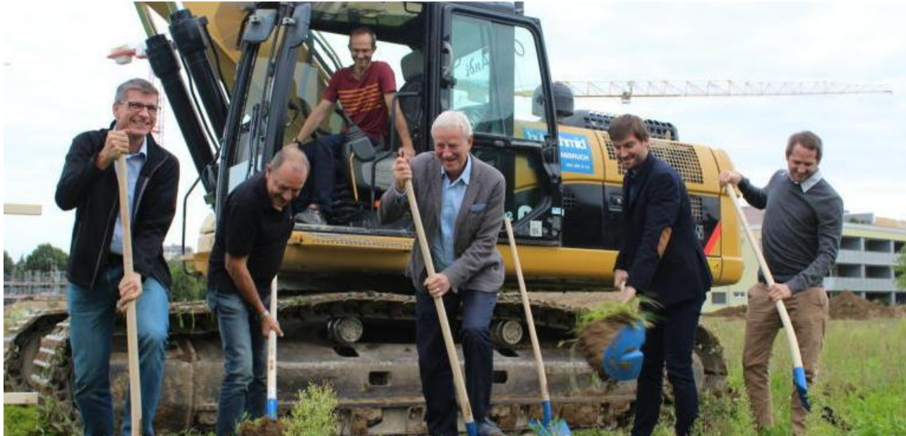
Der Spatenstich zum Grossprojekt!
