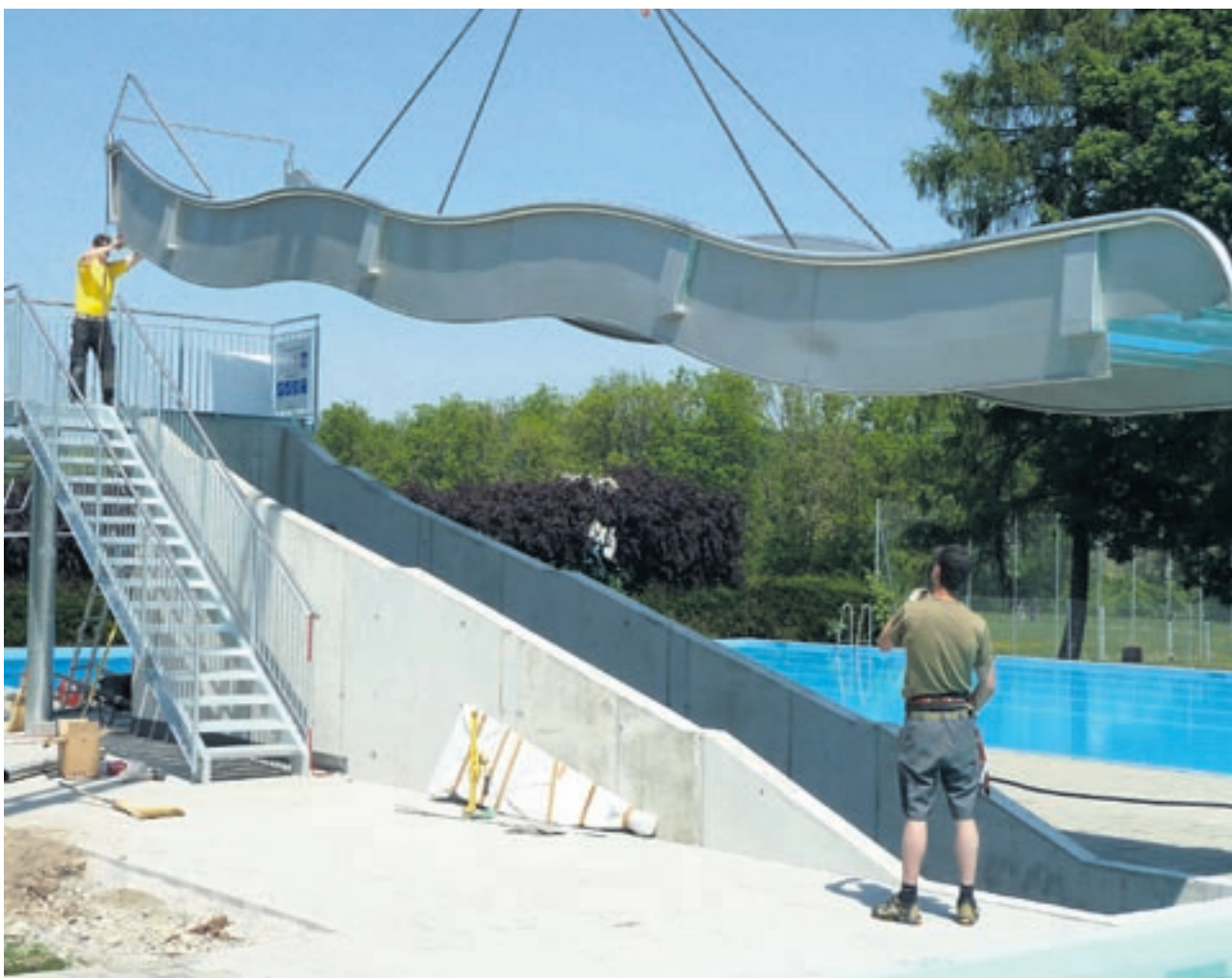
Mit Wellen versehen, 14 Meter lang, zwei Meter breit: Die Rutsche aus Edelstahl schwebt auf das Fundament aus Beton. Bild: IÜ
